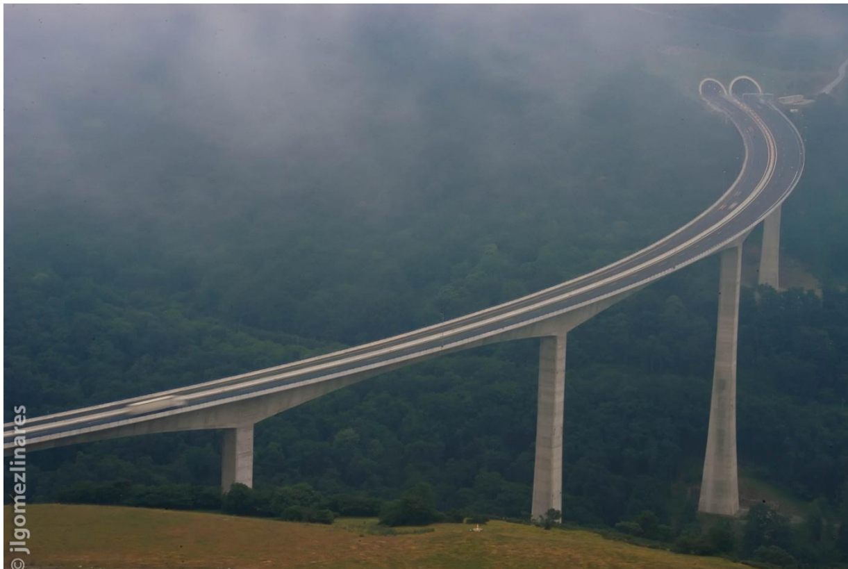
Viaducto de Montabliz (Cantabria)
